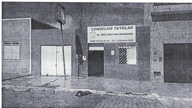
Foto- faixa da do prédio
